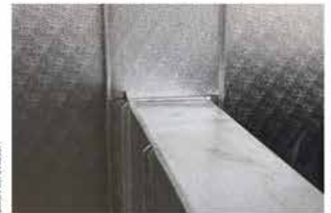
Perfekte Einführung der Attikaabdeckung
