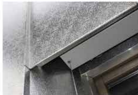
Passgenaue Anschlüsse am Fenstersturz
